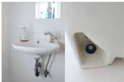
Bevestiging van een lavabo met Hema, schroefdraad en moer
