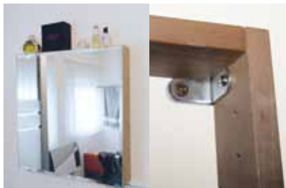
Bevestigen van een badkamermeubel met gewone schroef
