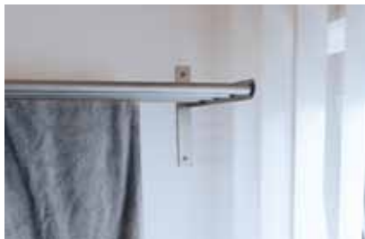
Bevestigen van een handdoekhouder met gewone schroef
