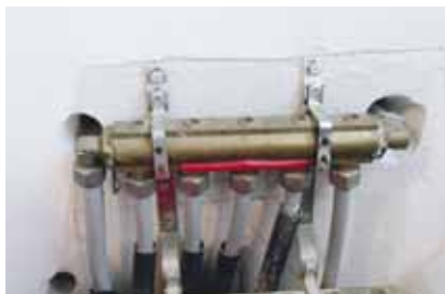
Bevestigen van een waterdistributeur met nylon schroef
