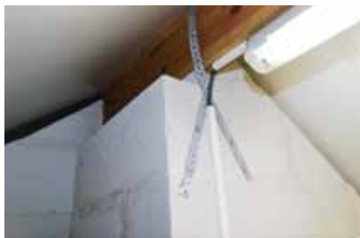
Bevestiging van een structurele lus met Hemanagels
