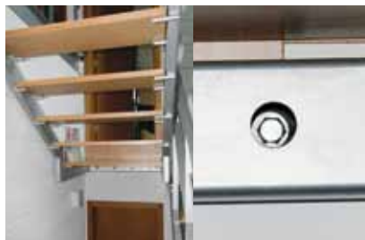
Bevestiging van een trap. met 4 nylon bevestigingsankers
